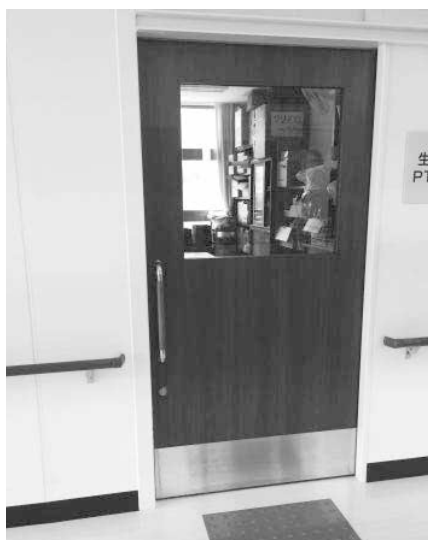
図4 壁と床、壁と扉の視認性の良い良好事例
